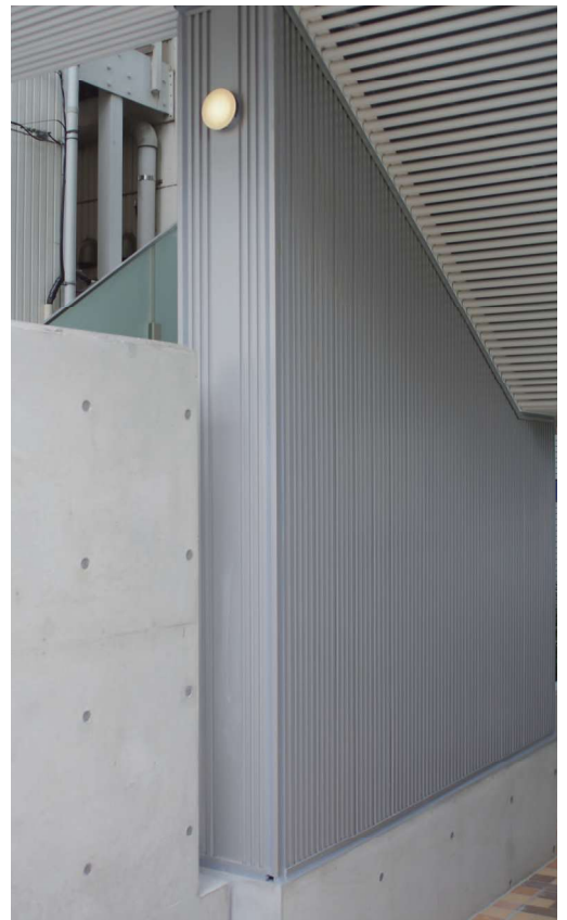
物件名：学校法人順天学園 順天中学校・高等学校 施工場所：東京都北区王子 施工業者：(株) コンテック 型式：AS-100 AS105 コラボ張り 色：指定色焼付塗装
