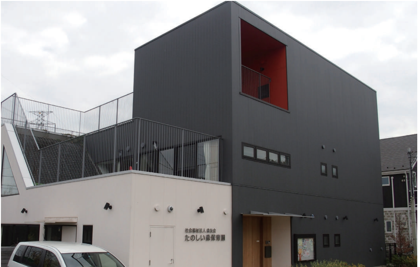
物件名：社会福祉法人 森友会 たのしい森保育園 施工場所：東京都小平市 設計事務所：戸室太一建築設計室 様 型式：OP-120 F型 目地：無 t：0.5 色：GM-5 メタリックシルバー
