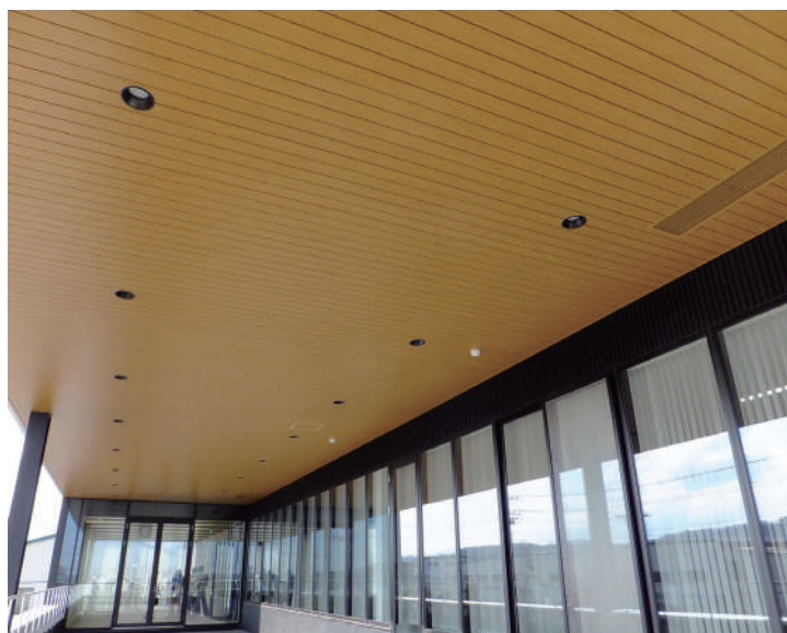
物件名：(株)ユタカ製作所 高崎工場 新築工事 元請け：大成建設株式会社様 施工業者：株式会社テラスワ様 AS105 BW-3 オーク色
