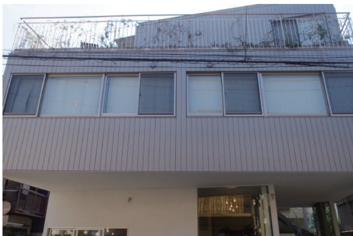
物件名：食堂付アパート 設計事務所：仲建築設計スタジオ様 施工業者：小川建設株式会社様 板金施工：山陽工業株式会社様 OP120 F型 目地5mm（特注） GM-4 ニューシルバー
