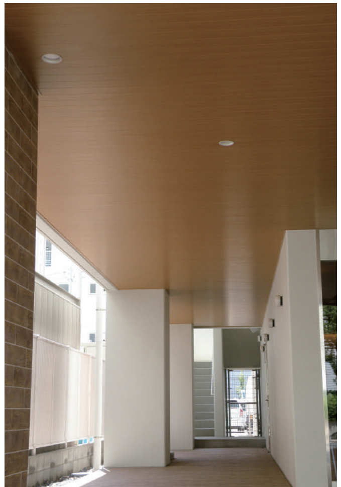
物 件 名：大宮こども専門学校大宮医療秘書福祉専門学校 新築工事 元 請 け：大成建設株式会社様 施工業者：株式会社テラスワ様 AP-100F 目地無 t:0.6 ASW-722
