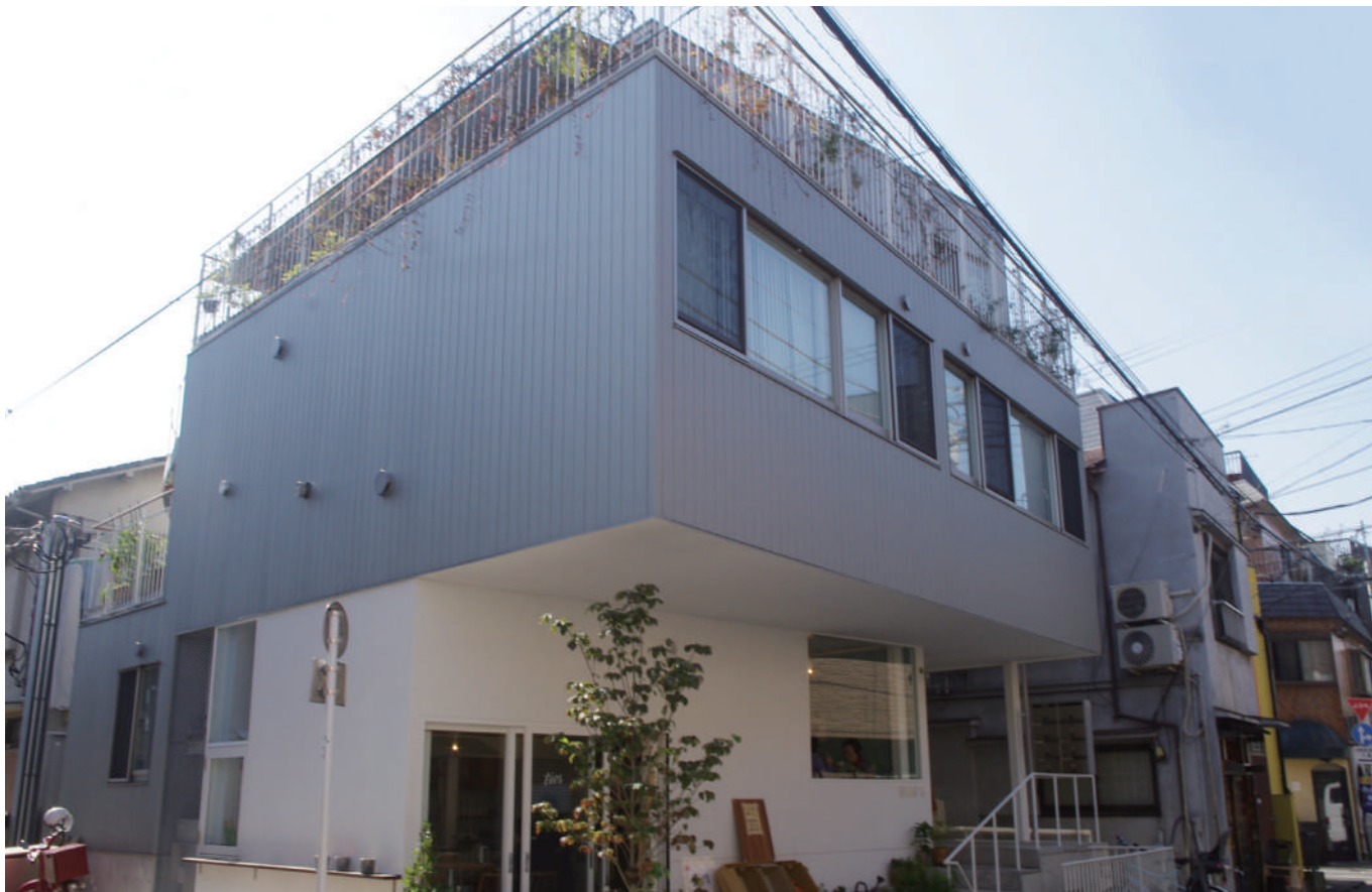
物件名：食堂付アパート 設計事務所：仲建築設計スタジオ様 施工業者：小川建設株式会社様 板金施工：山陽工業株式会社様 OP120 F型 目地5mm（特注） GM-4 ニューシルバー
