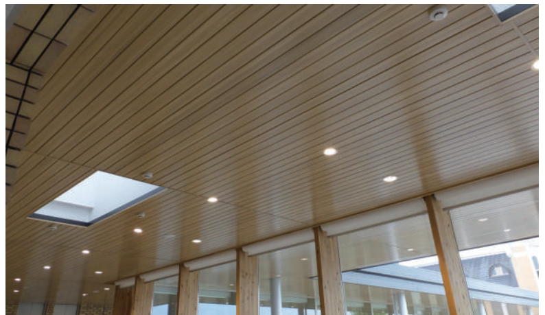
物件名：郡山市中央公民館・勤労青少年ホーム新築工事 施工場所：福島県郡山市 型式：AP-100F 目地：有 t:0.6 色：AM-03
