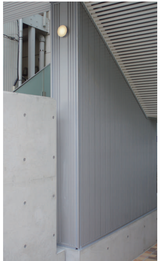
物件名：学校法人順天学園 順天中学校・高等学校 施工場所：東京都北区王子 施工業者：(株) コンテック 型式：AS-100 AS105 コラボ張り 色：指定色焼付塗装
