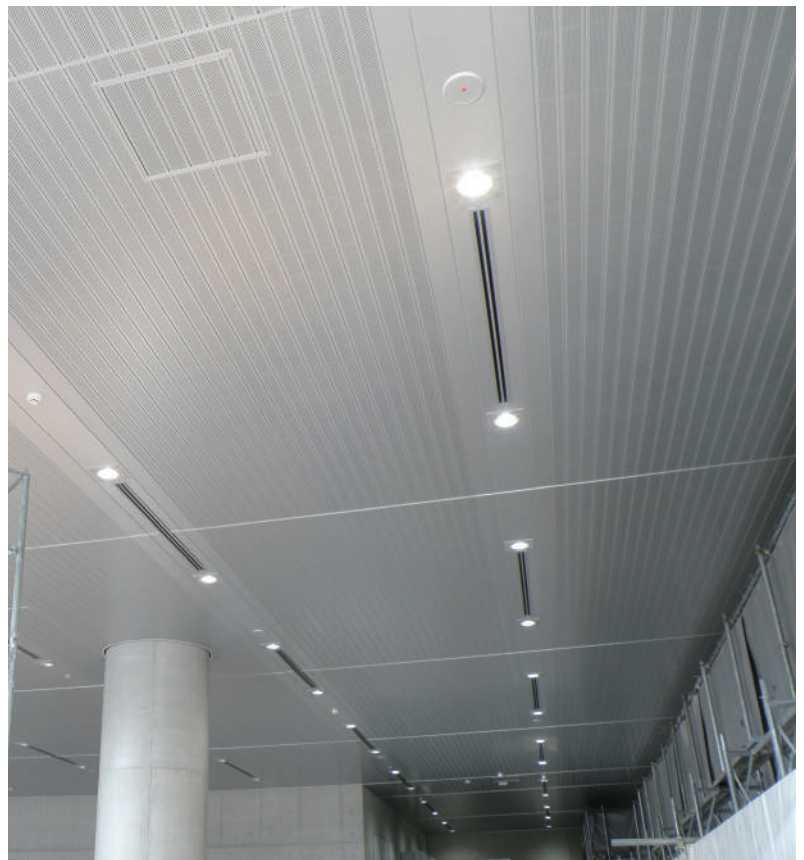
物件名：葛西臨海水族園空調設備改修工事 施工場所：東京都江戸川区 型式：AP-100F 目地：有 t：1.0 有孔：No.2 コラボ張り AP-300F 目地：有 t：1.2 色：P-31
